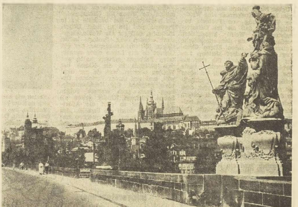
VON DER KARLSBRÜCKE IN PRAG AUS
