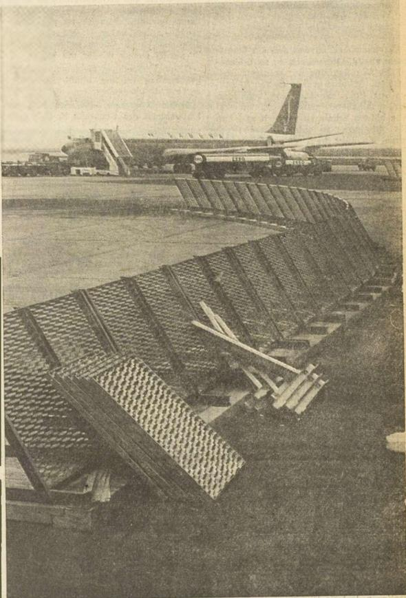
Entlang der Startbahn des Nationalflughafens Brüssel wurden diese Stahlgitter angebracht, die vor dem gefährlichen Luftzug der Düsenmaschinen schützen sollen.
