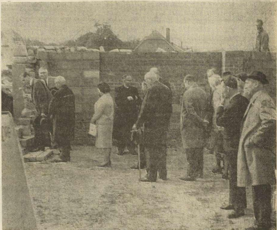
Die Mitglieder des Verwaltungsrates bei der Grundsteinlegung
