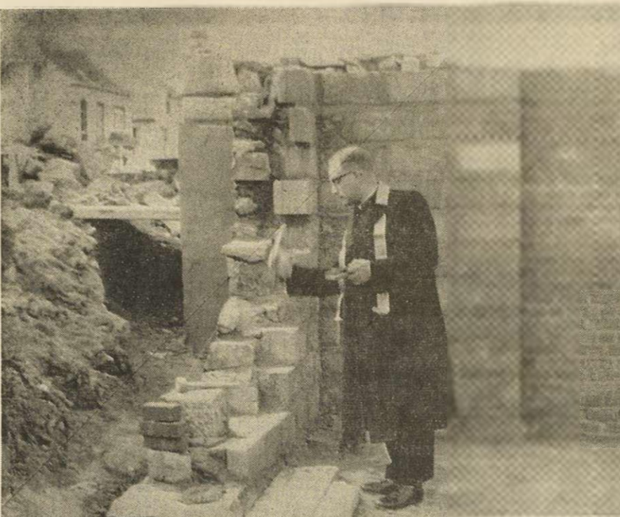
Hochw. Dechant Breuer segnet den Grundstein
