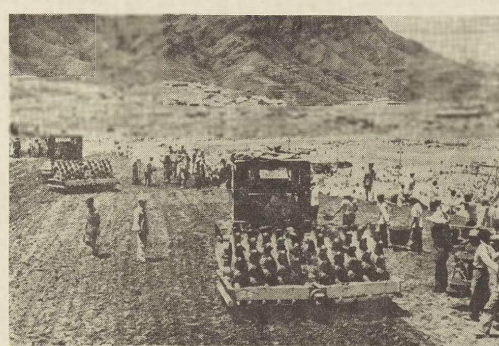
IN KOLLEKTIVARBEIT DURCHFÜHRT
