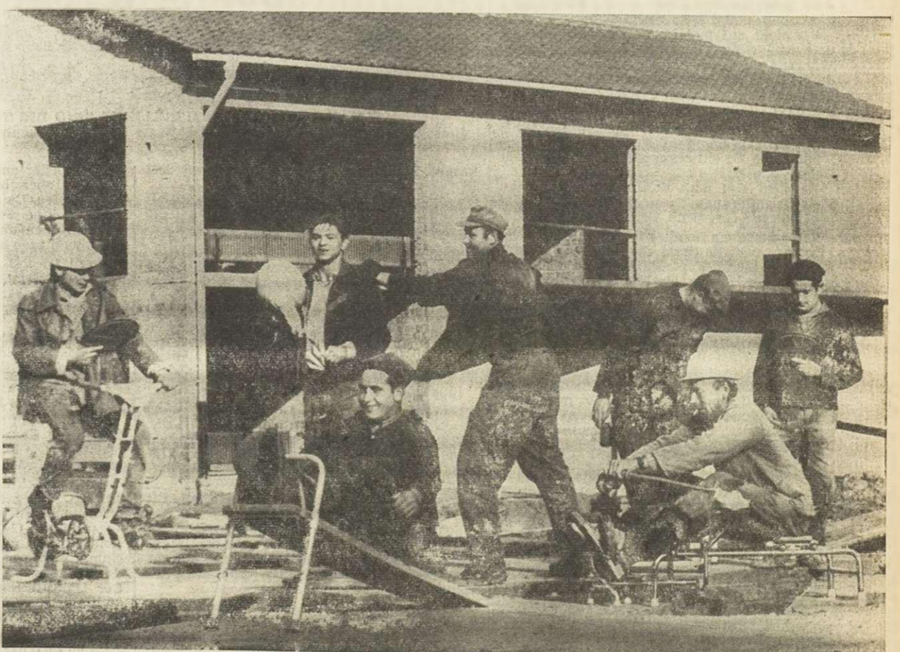
Sport und Arbeit Auf einer Baustelle in Vilbel (Deutschland) ließ ein Bauunternehmer Sportgeräte aufstellen, womit die Arbeiter sich während der Mittagspause beschäftigen konnten. Es wurde jedoch kein Ansteigen des Arbeitspensums vermerkt.
